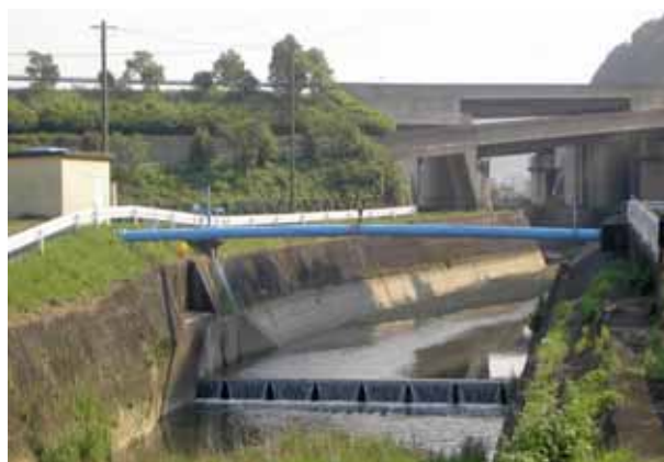
Pic.1 袴野頭首工の全景
