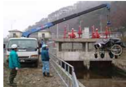
図-3 計測装置の吊りこみ状況
