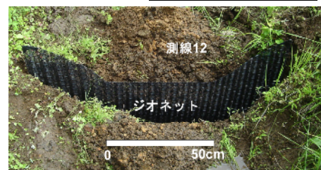
図2 設置したジオネットの形状と状況 Shapes of the installed geonet
