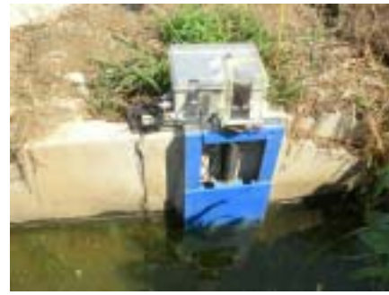
図4 . 自動取水口の現場設置
