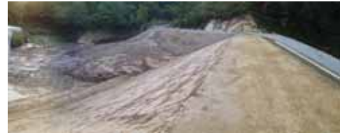
写真-1 築堤完成状況 (Photo.1 Embankment completion)
