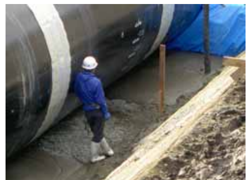
写真 1 LSS 埋戻し状況 (会所掘り部)
