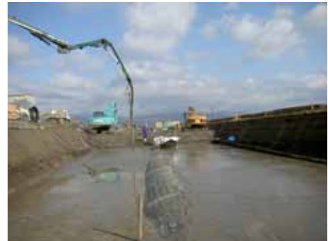
事例 1 LSS 埋戻し状況( 3500)
