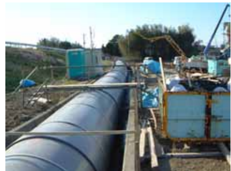
事例 2 LSS 埋戻し状況( 1800)
