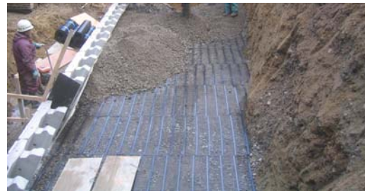
写真-3 ジオグリッド敷設, 砕石撒出し (Photo-3 Installation of geogrid, back filling)
