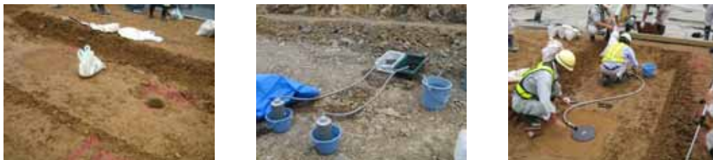
写真-1 ワイヤレス埋設計器の設置状況 (左から、設置用トレンチ、土圧計付随型ワイヤレス埋設計器、設置作業)
