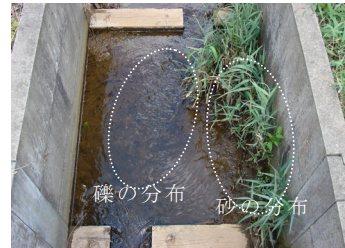
Fig.4 出水による横断水路地形の変化
