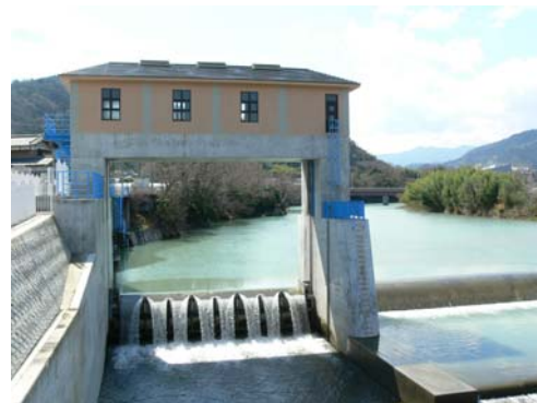
（写真－4）伝統家屋を模した上屋
