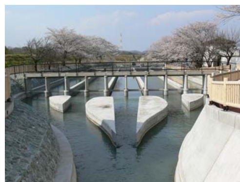
（写真－3）完成した沈砂池
