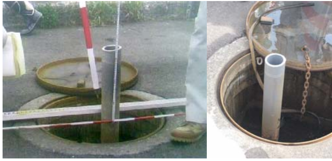
a) No.12+10.0 断面 (堤頂中央) b) No.16 断面 (右岸地山側)
