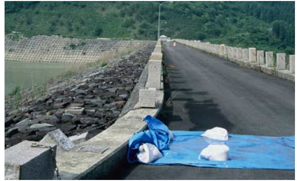
写真-2 高欄石柱の転倒、傾倒、堤頂保護アスファルトの上下流亀裂発生箇所 (ブルーシート部) Earthquake disaster on crest of dam
