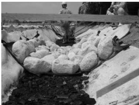
写真-1 炭の敷き均し状況
