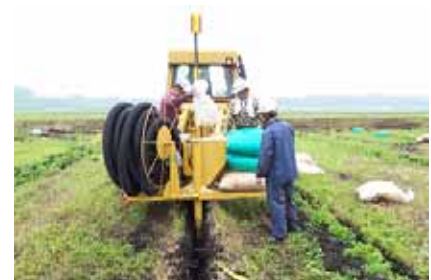
Photo 1 FOEAS 施工状況 （幹線パイプ）
