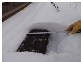
(b) 一部露出区間 (右岸側・側壁天端、3月4日)
