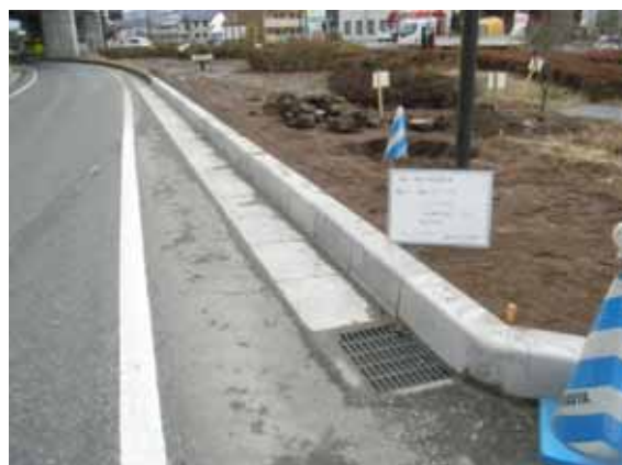
写真-1 試作製品の敷設状況
