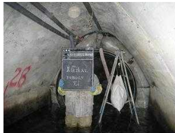
Pic. 6 エル外パツ間仕切り
