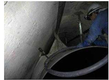
Pic. 5 浮上防止固定
