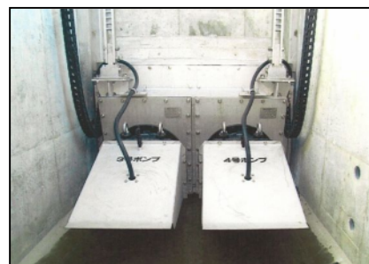
写真-2 低水位型ポンプゲートφ600
