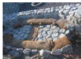
図12 水質浄化水路
