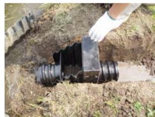
写真-4 水田側の継ぎ手と落水口
