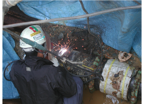
図1 計測対象鋼管の補修状況
