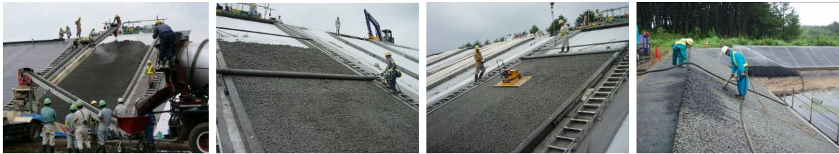
テレベルトで POC を投入 ストライカーチューブで敷均し コンパクターで締固め スラリー化した黒土を充填
