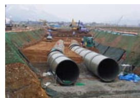
写真一 大口径パイプ施工状況
