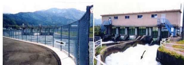
Fig.1 幹線水路の取水分水状況（従前：開水路）
