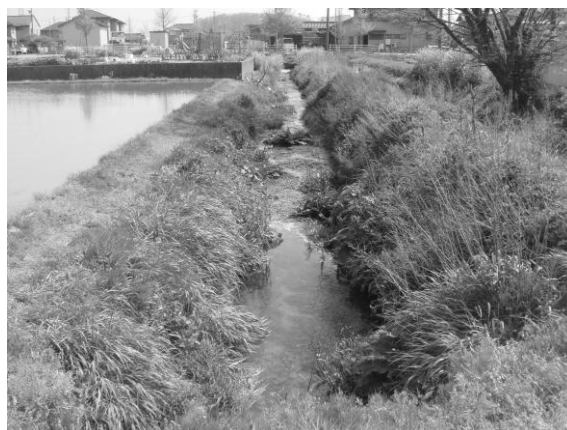
Photo.1 湧水路上流区間
