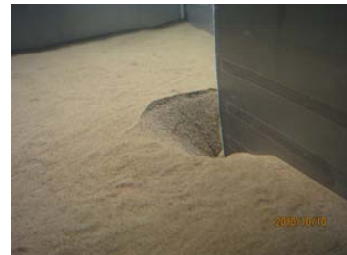
Fig.4 上流側地盤沈下形状(角部)(E0311)
