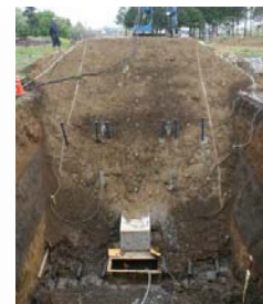
Fig.2 模型堤体（下流斜面） Photo of the test embankment
