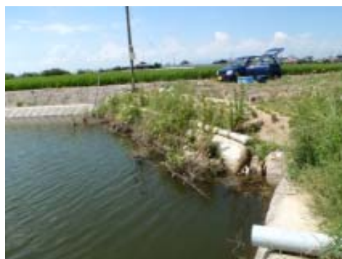
写真-2 施工半年後の法面
