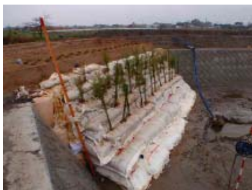
写真-1 施工時の法面
