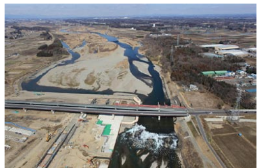
Fig.6 勝瓜頭首工の鳥瞰撮影結果(撮影日2)
