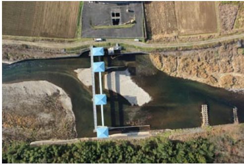
Fig.3 森田頭首工の鉛直撮影結果(撮影日1)
