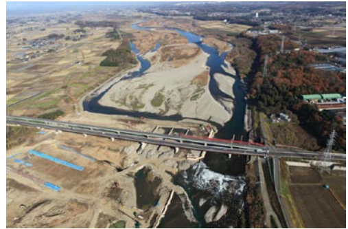
Fig.5 勝瓜頭首工の鳥瞰撮影結果(撮影日1)
