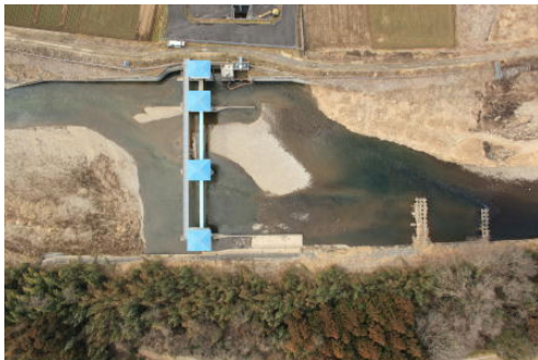
Fig.4 森田頭首工の鉛直撮影結果(撮影日2)
