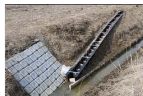
写真－1 魚道の設置状況
