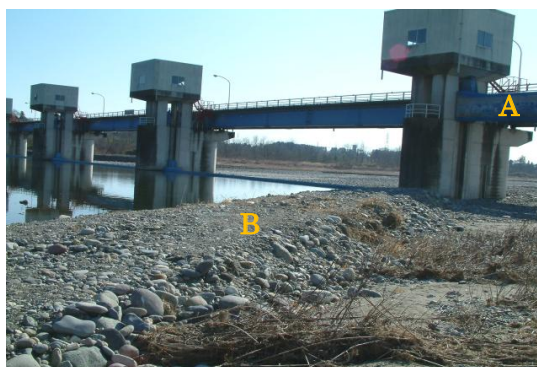
図-2 仮設砂利堤の設置による取水機能維持 A: 吊り上げ状態の洪水吐 6 号ゲート, B: 仮設砂利堤 (岡本頭首工上流の様子, 2012.1.31 三輪撮影)
