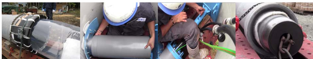
Fig.3 ファイン工法の施工状況
