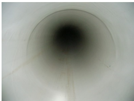
写真－2 施工後の管内
