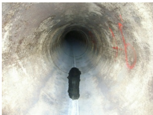
写真－1 施工前の管内
