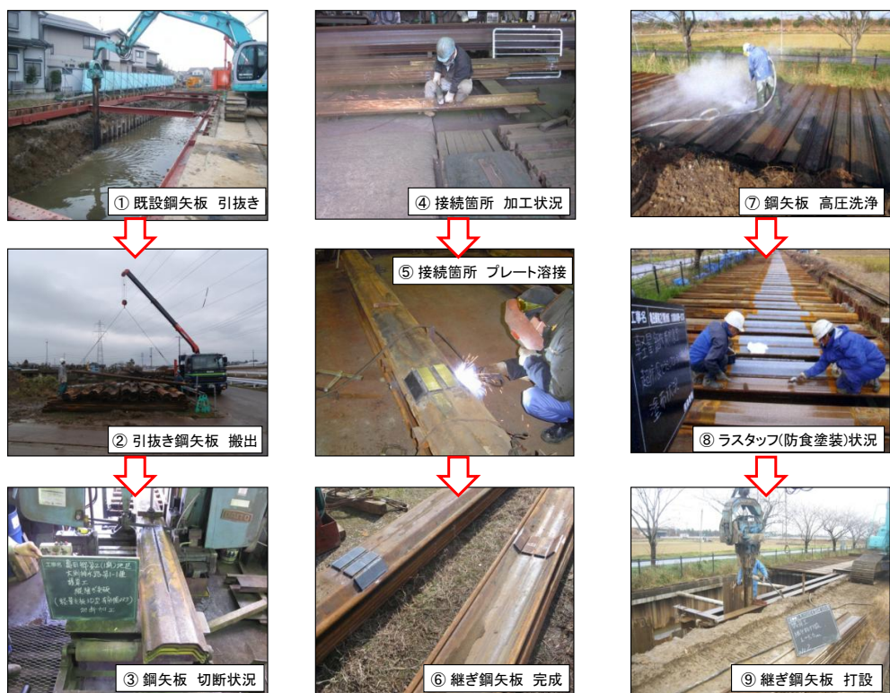
図 - 3 鋼矢板リサイクル工法の施工状況
