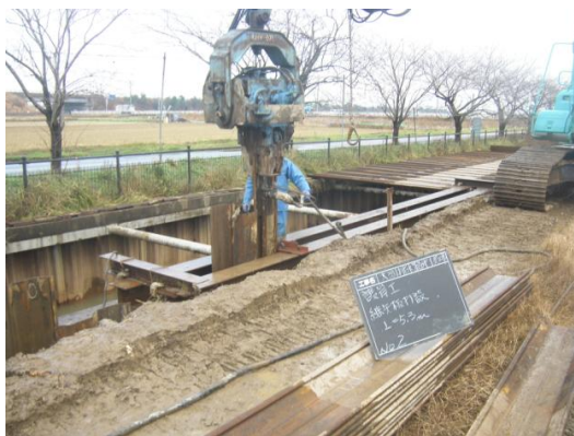
図 - 1 継ぎ矢板の施工状況
