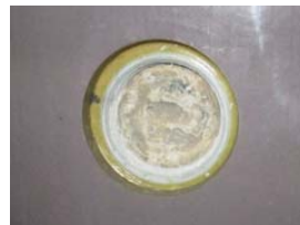
Pic. 1 グラウトホール
