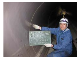
Pic. 2 ジョイント間隔測定
