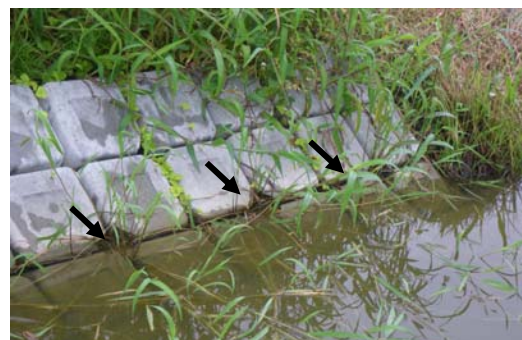
図3. 設置約1年後のブロックマット Fig. 3. Gobi-mat one year after the construction
