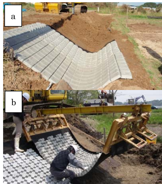
図2. ブロックマット(a)とその作業状況(b) Fig. 2. Gobi-mat(a) and its construction
