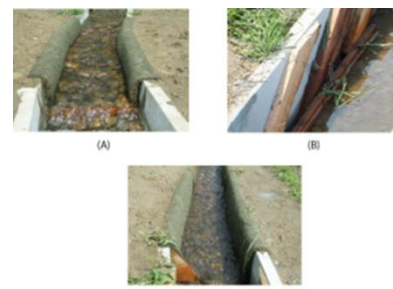
Fig. 2 側壁の修復方法。
