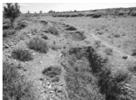
写真1 集水ピットの設置状況
