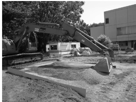
図 3 法面バケットによる CB 層の敷設
