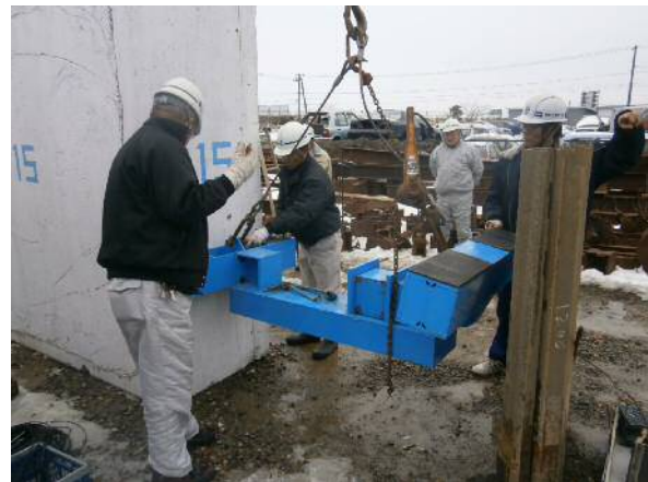
(2) 加圧ジャッキの設置状況
