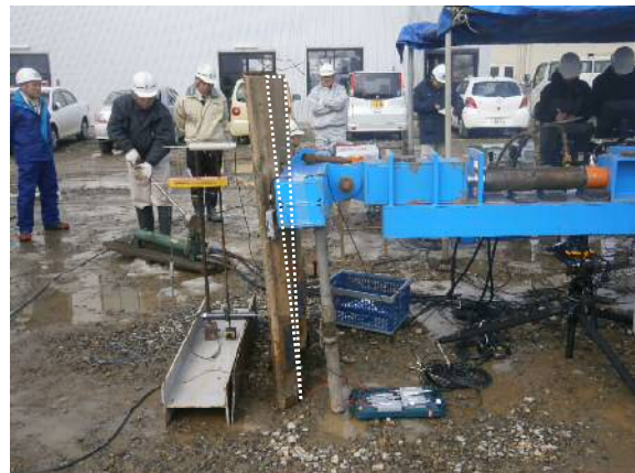
図 - 2 継ぎ矢板の曲げ状況（50kN 荷重時）
