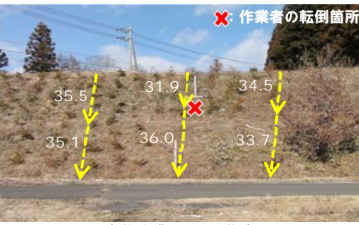
図 5 除草作業中の滑落事故現場 Fig.5 The accident site of nasty fall the mowing
