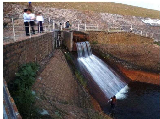
写真3 底樋による利水放流 Photo3. Sluiceway through the dam for water utilization
