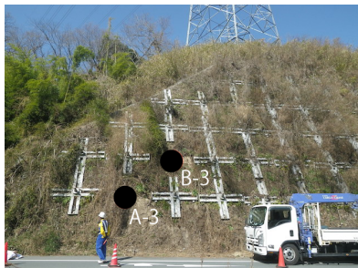
写真-1 現地状況
