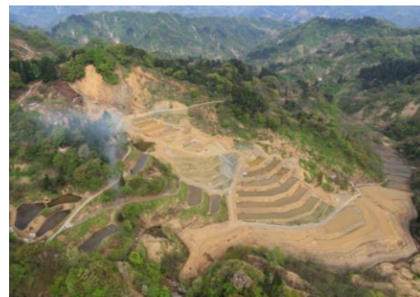
写真 - 2 復旧後の清水棚田
