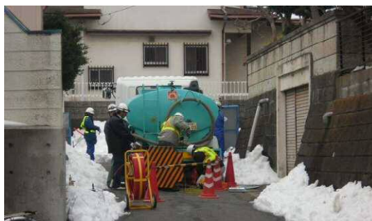
写真-3 現場状況 Photo.3 Test Site
