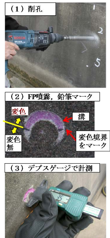
図 3 被覆工の中性化深さ測定(コアビット法)
