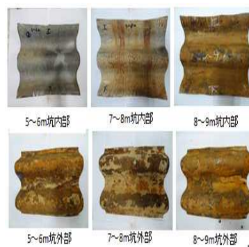
鋼材抽出状況（坑内・坑外）
