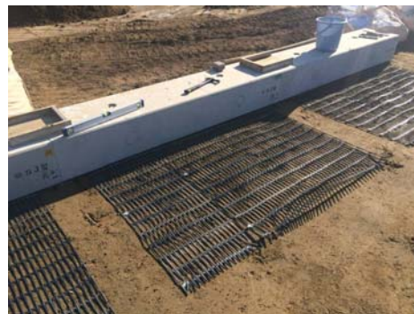
写真-1 ジオテキスタイル付きブロックの施工例
