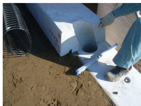
写真-2 ブロックの連結孔
