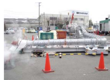
Pic.1 試験配管 Piping test
