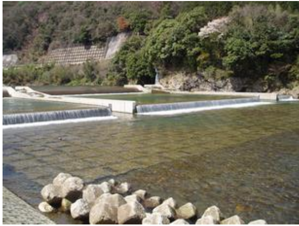
頭首工の魚道設置
