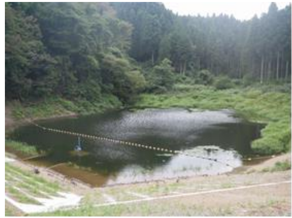
ため池堤体の改修
