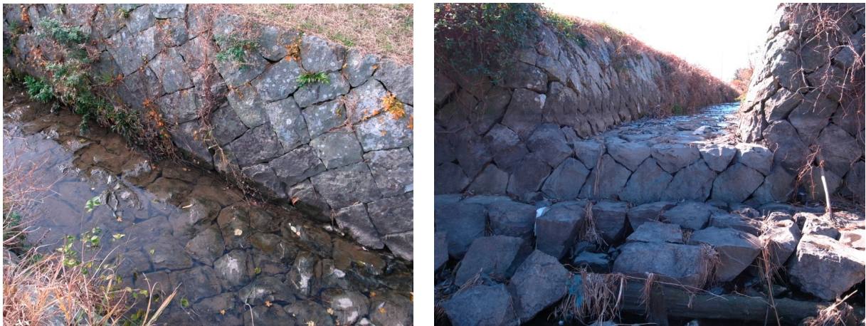
図 1 石積み三面張り水路。河川接合部は河川護岸と一体的に整備されている
